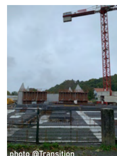
CD64 Construction du collège d'Arette
